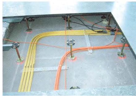
Bild 4. Geöffneter Doppelboden [Quelle: Dipl.-Ing. (FH) B. Schmelmer, Institut für Systembodentechnik, Odenburg am Main]
