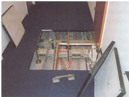
Bild 6. Geöffneter Doppelboden [Quelle: Dipl.-Ing. (FH) B. Schmelmer, Institut für Systembodentechnik, Odernburg am Main]
