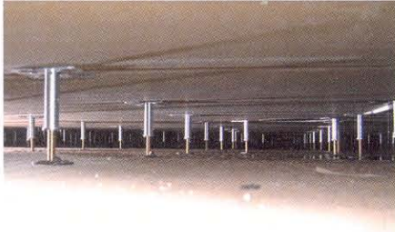
Bild 1. Schematische Darstellung Hohlboden [Quelle: Dipl.-Ing. (FH) B. Schmelmer, Institut für Systembodentechnik, Odenburg am Main]
