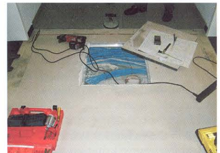
Bild 5. Revisionsöffnung in Hohlboden [Quelle: Dipl.-Ing. (FH) B. Schmelmer, Institut für Systembodentechnik, Odenburg am Main]
